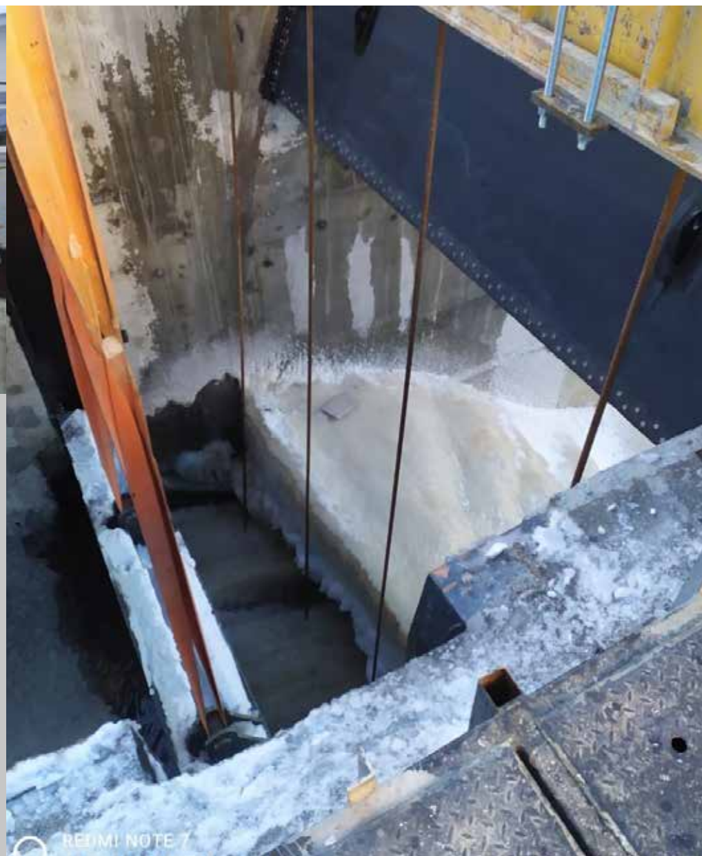
Подъем затвора шлюза массой 150 тонн на высоту 12 метров, Белопорожская ГЭС1, Республика Карелия.
