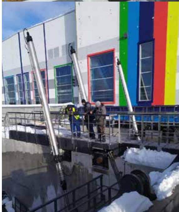
Подъем затвора шлюза массой 150 тонн на высоту 12 метров, Белопорожская ГЭС1, Республика Карелия.
