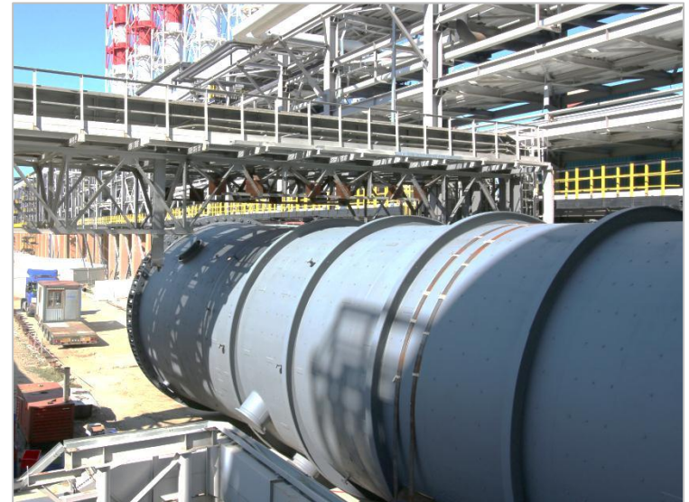
► Перемещение колонны масса 470 тонн , дистанция более 100 метров, ограниченный габарит под трубопроводом
