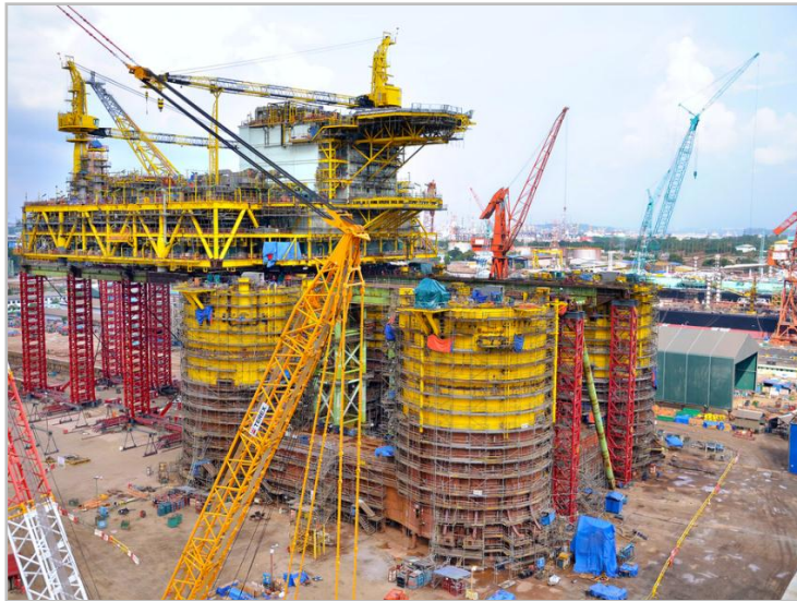
▼ Верхнее строение платформы Malikai, Малазия Масса - 14 300 тонн
