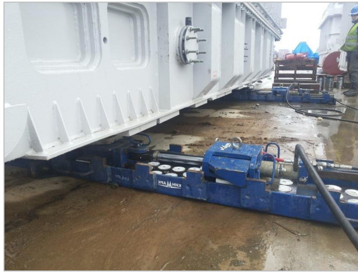
▼ Установка в проектное место дизельгенераторных установок. Масса - 140 тонн
