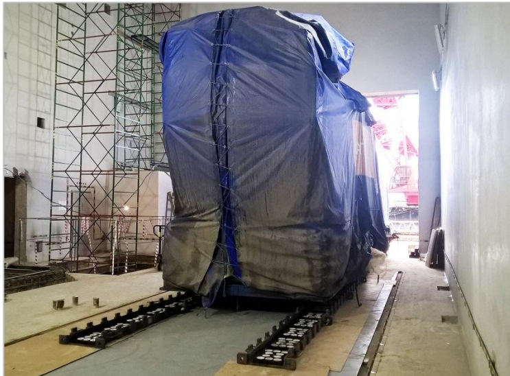
▲ Перемещение трансформатора. Масса - 300 тонн
