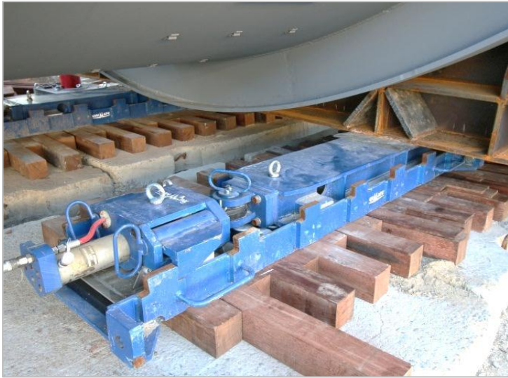
► Перемещение колонны масса 470 тонн , дистанция более 100 метров, ограниченный габарит под трубопроводом
