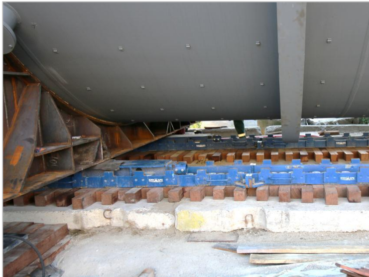
► Перемещение колонны масса 470 тонн , дистанция более 100 метров, ограниченный габарит под трубопроводом
