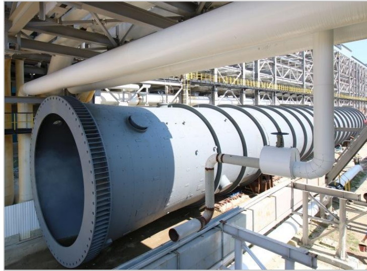
► Перемещение колонны масса 470 тонн , дистанция более 100 метров, ограниченный габарит под трубопроводом
