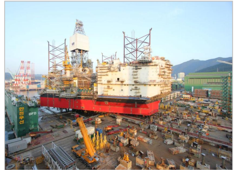
▼ Верхнее строение буровой платформы, Cat-J Statoil Масса - 30 000 тонн
