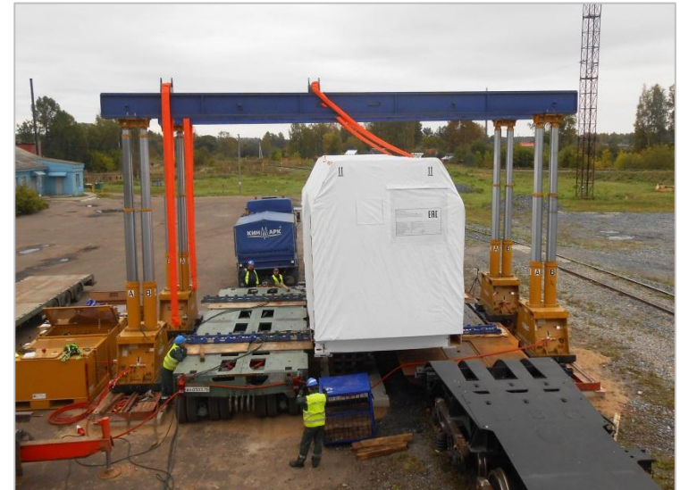
▼ Перегрузка трансформатора с автотрейлера на временную площадку. Масса - 300 тонн
