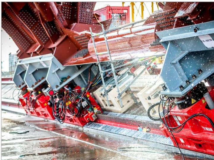
▲ Перемещение конструкций укрытия Чернобыльской АЭС Масса – 19 000 тонн, расстояние – 330 метров
