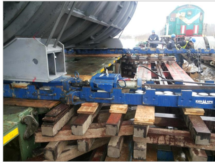
▼ Перегрузка трансформатора с автотрейлера на временную площадку. Масса - 300 тонн
